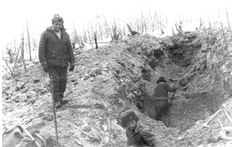
Рисунок 9 – Зачистка и приемка канавы, пройденной буро-взрывным способом. Слева Ведущий геолог Попов В.Т.
