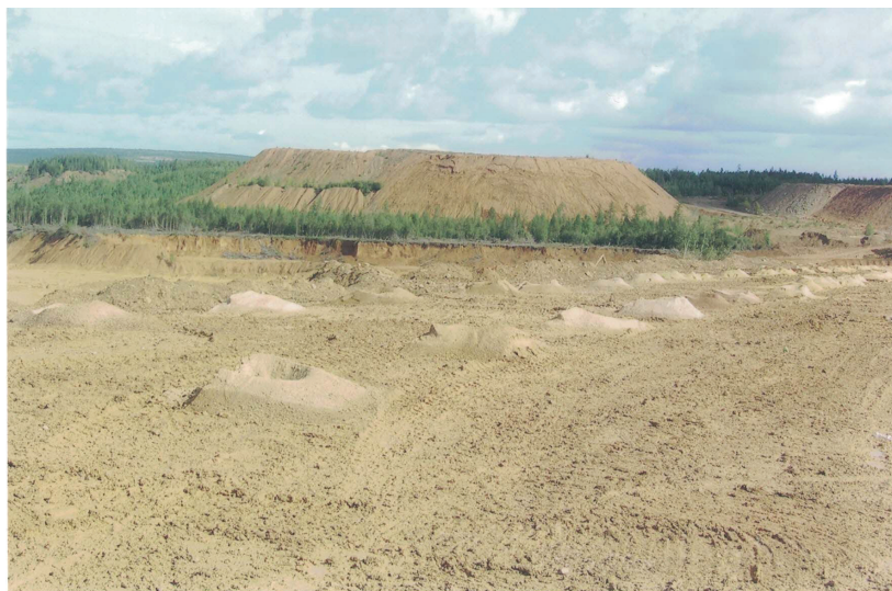
Рис. 3. Подготовленные к взрыву горные породы месторождения «Дэлбэ»
