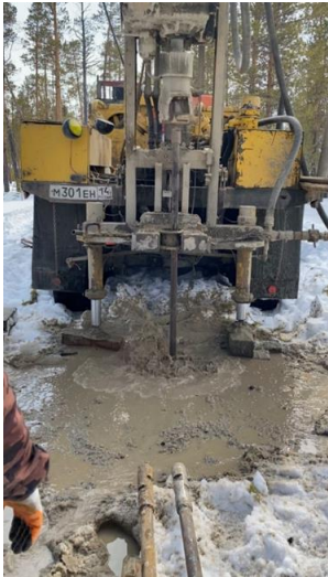
Рис. 8. Вскрытие талика бурением скважины Fig. 8. Opening of the talik by drilling a borehole
